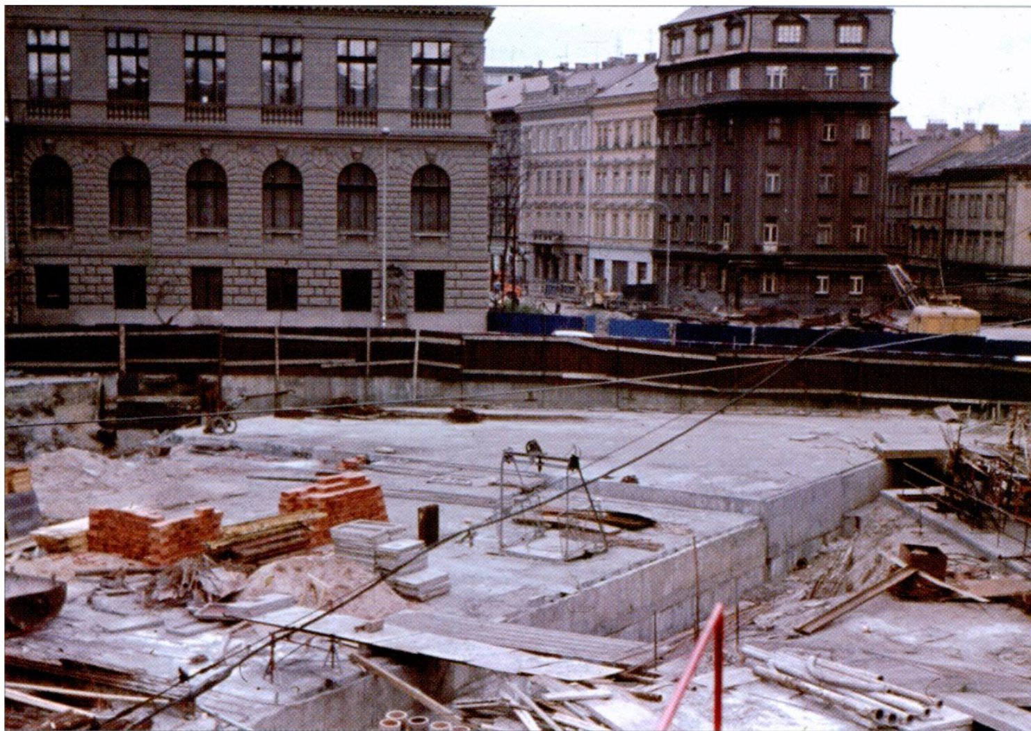
Výstavba stanice metra C Sokolovská, dnešní Florenc, ve třetí etapě (10. 10. 1972)
