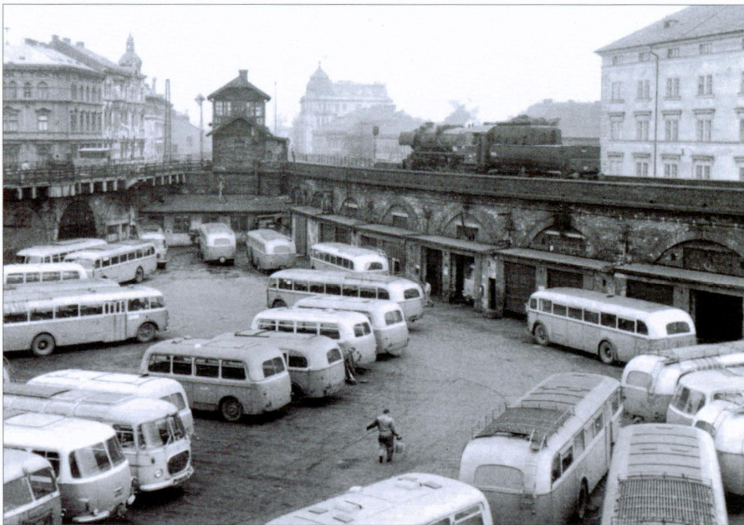
Dílny a garáže autobusů v tzv. „deltě“ mezi rameny Negrelliho viaduktu (60. léta)
